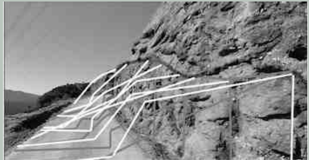
L'excavació en roca, al tram del coll Pedrís.
