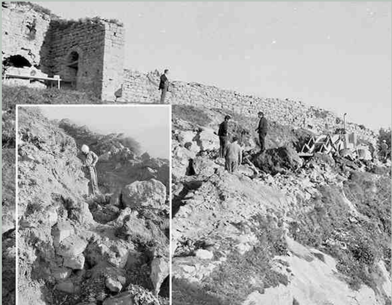
El complicat accés a la part alta. Moviment de terres i perforacions amb martell pneumàtic en els trams de roca.
