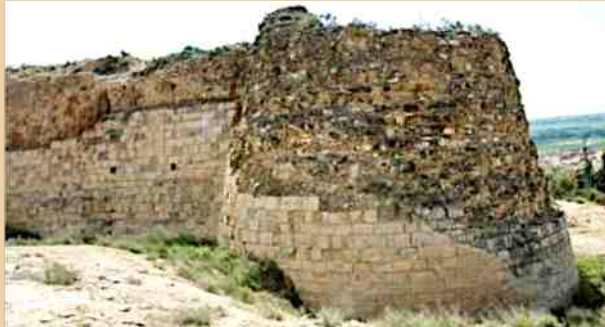
La torre sudoeste del castillo de Aitona con la prueba evidente del espolio de sillares autorizado por el marqués (J.R.González)
