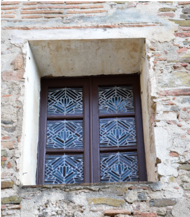
Ventana de Felipe II. Fot. Antonio Arévalo.
