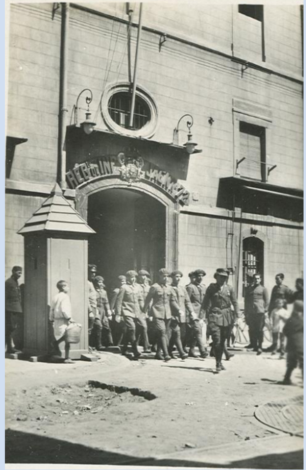
Cuartel de San Fernando
